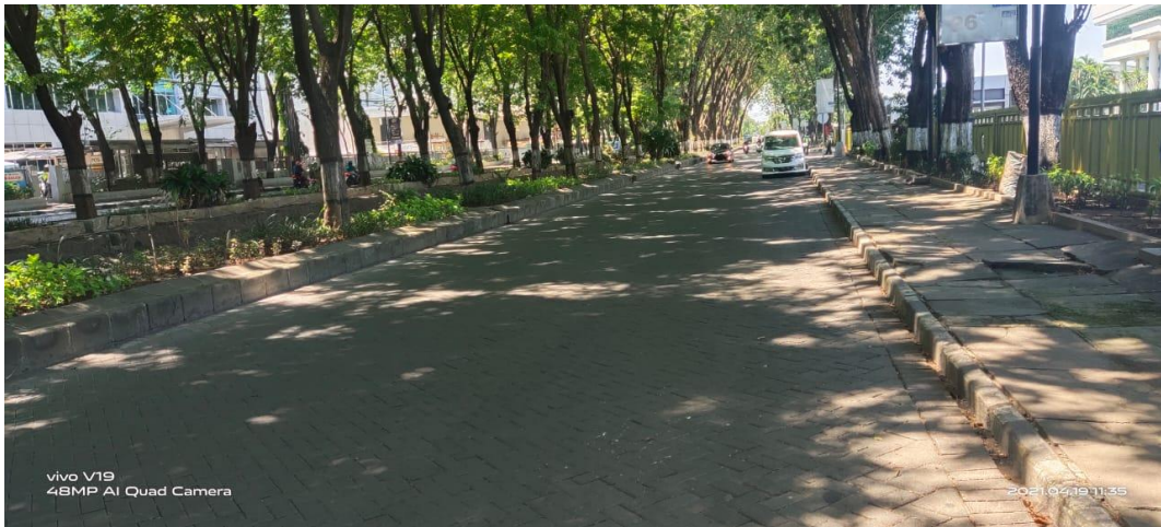
Kondisi Ruas Jalan Rungkut Industri Raya
