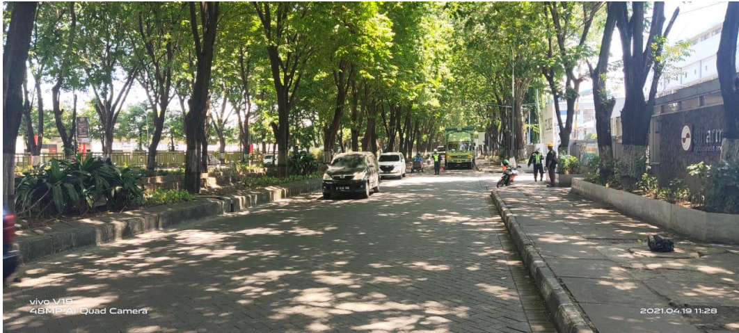
Kondisi Ruas Jalan Rungkut Industri Raya
