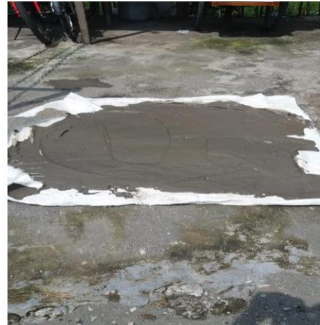
Proses penjemuran lumpur pengolahan Air
