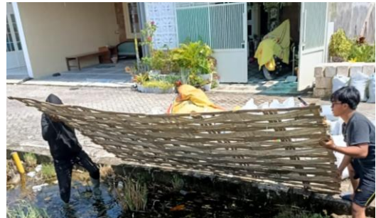
Anyaman bambu sebagai tatakan agar reaktor tidak ambles
