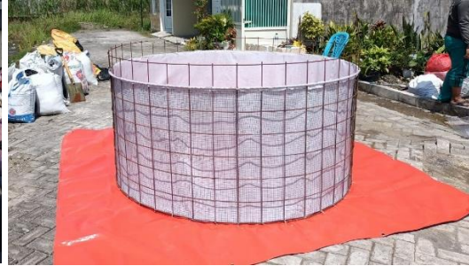
Pelapisan reaktor dengan terpal
