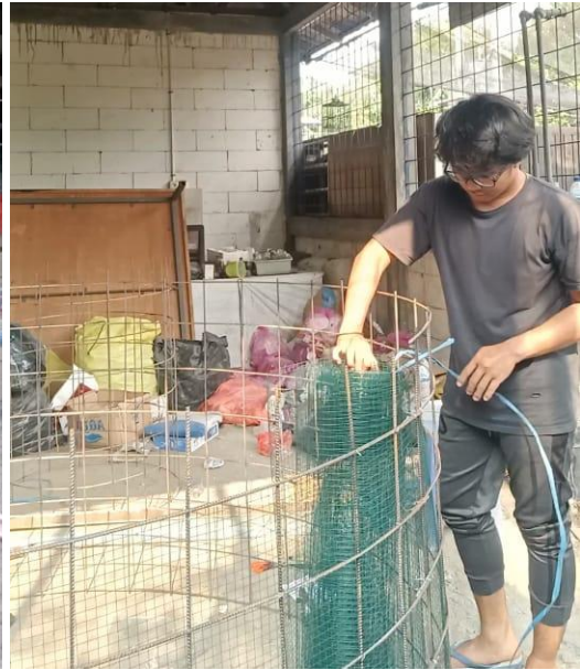
Pemasangan wire mesh dengan diameter kecil sebagai penyanggah media pasir
