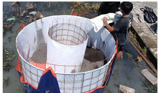
Media pasir dimasukkan dan diratakan
