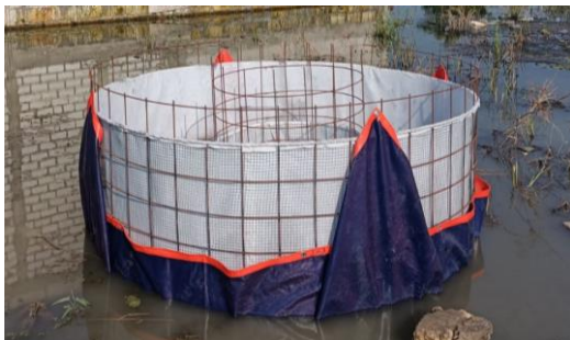
Reaktor diletakkan di atas tatakan
