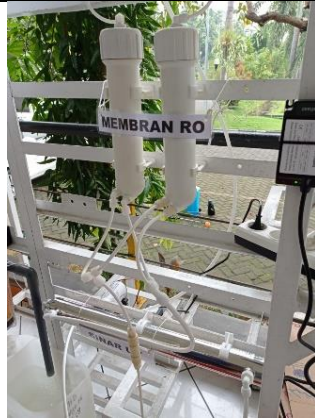
Pemasangan RO & Sinar UV
